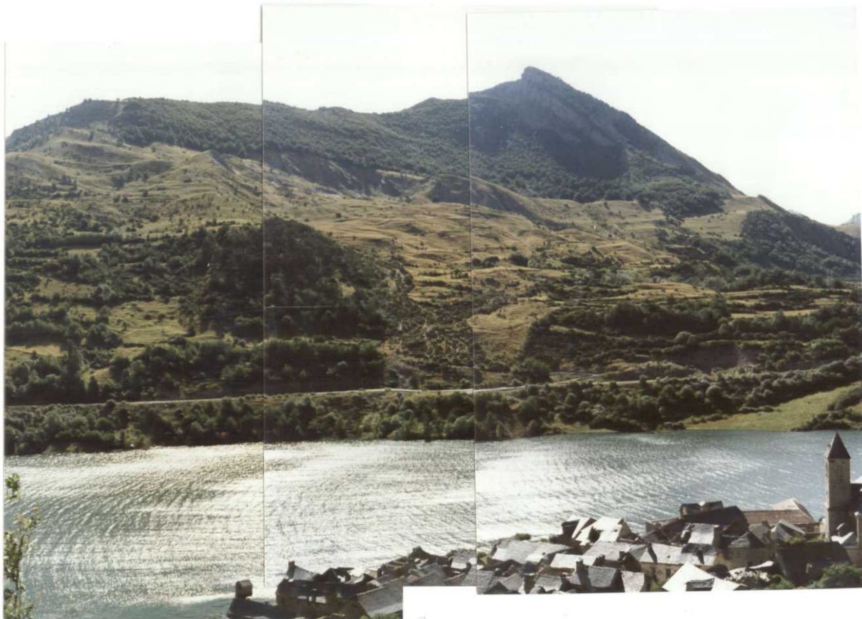
PANORAMICA 2. : Vista general de todo el paleo-deslizamiento. En primer término el deslizamiento actual. Obsérvese el pronunciado badén en la carretera. Toda la superficie superior se encuentra movida es característico las formas alomadas formando lóbulos de soliflucción. Obsérvese, asimismo, que el que actualmente desliza presenta una pendiente general mucho mayor que el resto de la masa deslizada.
